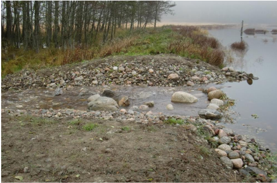
Figur 18. Ett omlöp i Botkyrka. Den övre delen av omlöpet är det som styr nivån på våtmarken.
