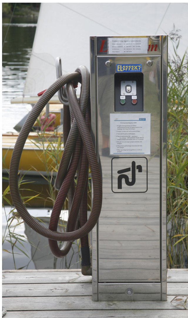
Tömningspumpanläggning.
